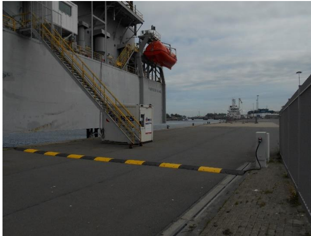
Figuur 10 Walstroomtoevoer naar het platform Paragon C462
